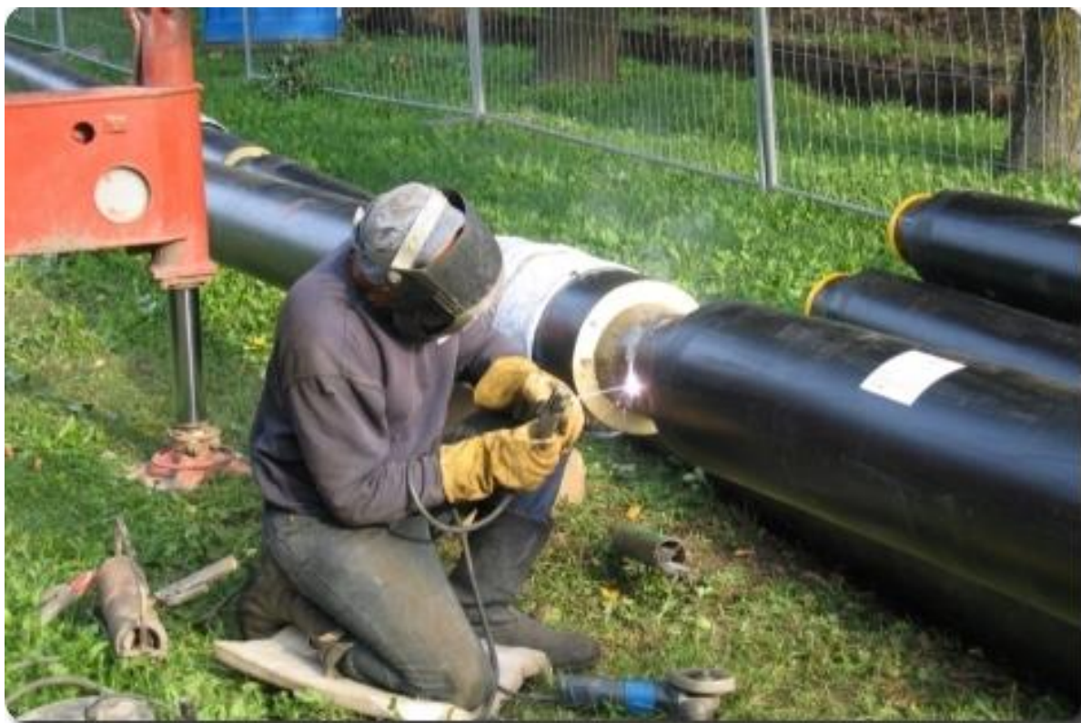
2 pav. Šilumos tiekimo vamzdžių suvirinimas. Šaltinis: dev.klenergija.lt
